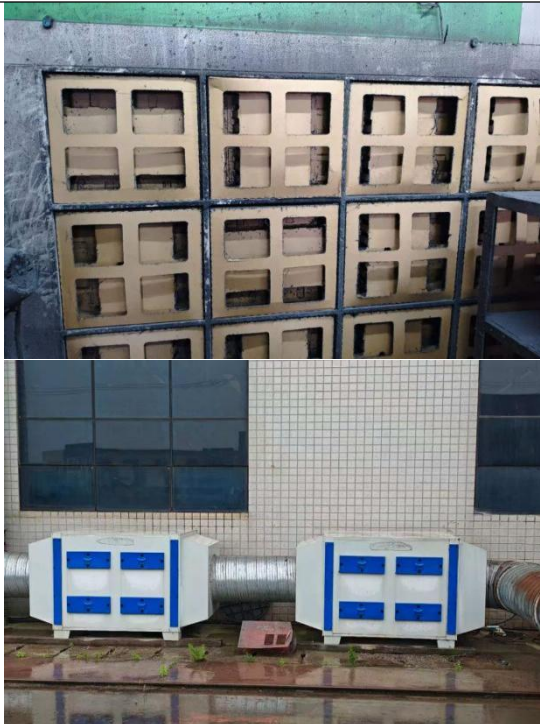
过滤棉过滤+两级活性炭吸附装置
