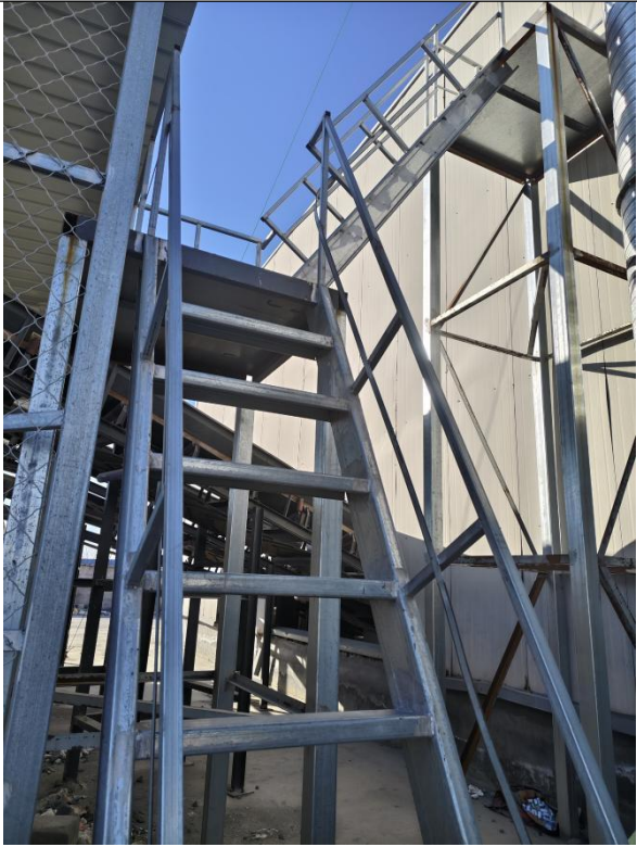
建筑垃圾废气采样平台
