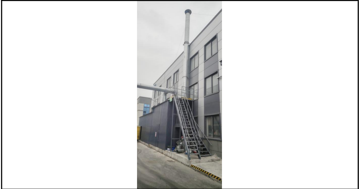
车间废气排气筒 DA001
